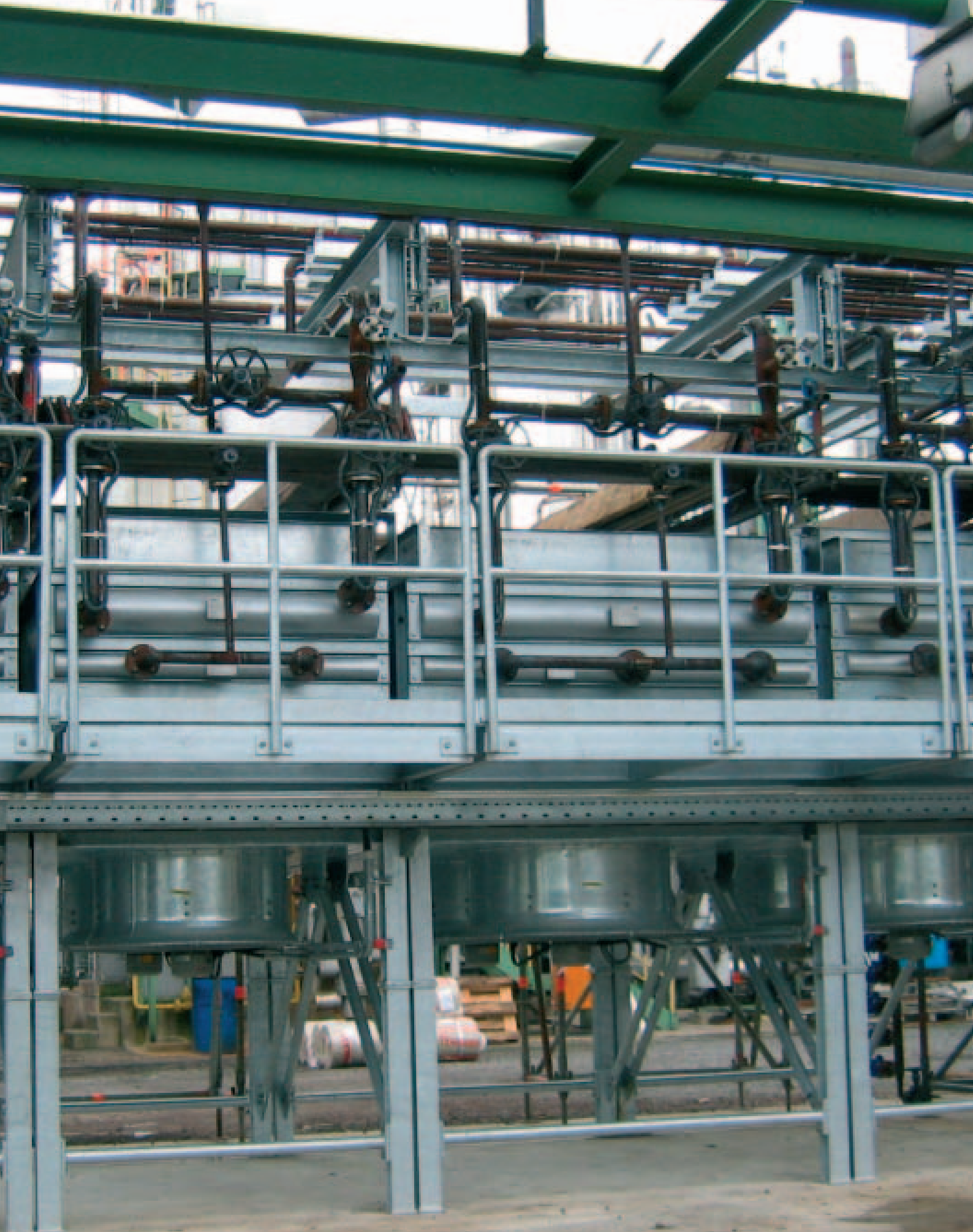
Luftgekühlte Anlage für hochviskose Öle
